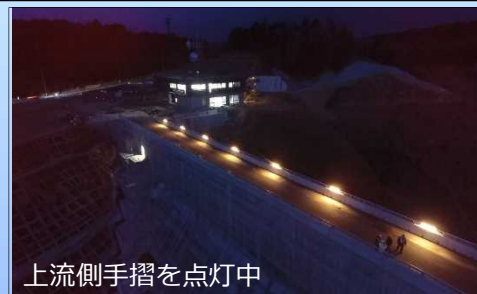
手摺の中のLED灯
